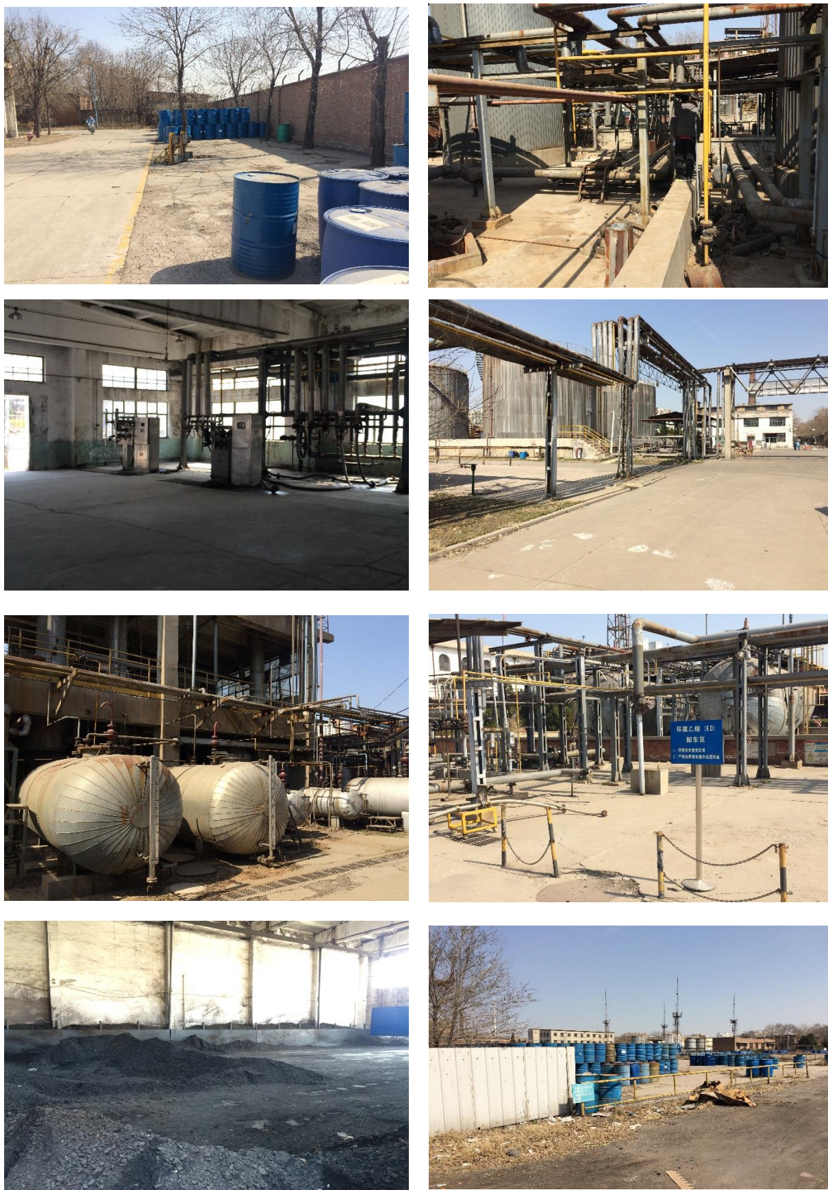
图 2-4 生产期间场地布局照片（2016 年）
