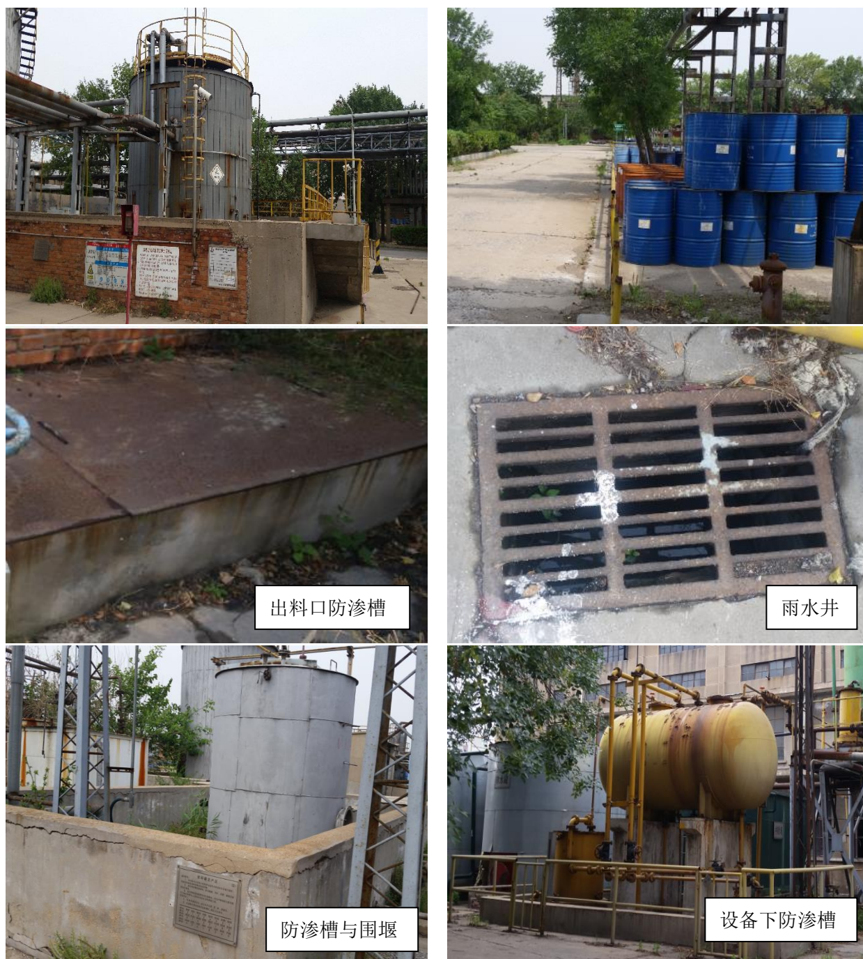
图 2-23 潜在污染源现状照片
