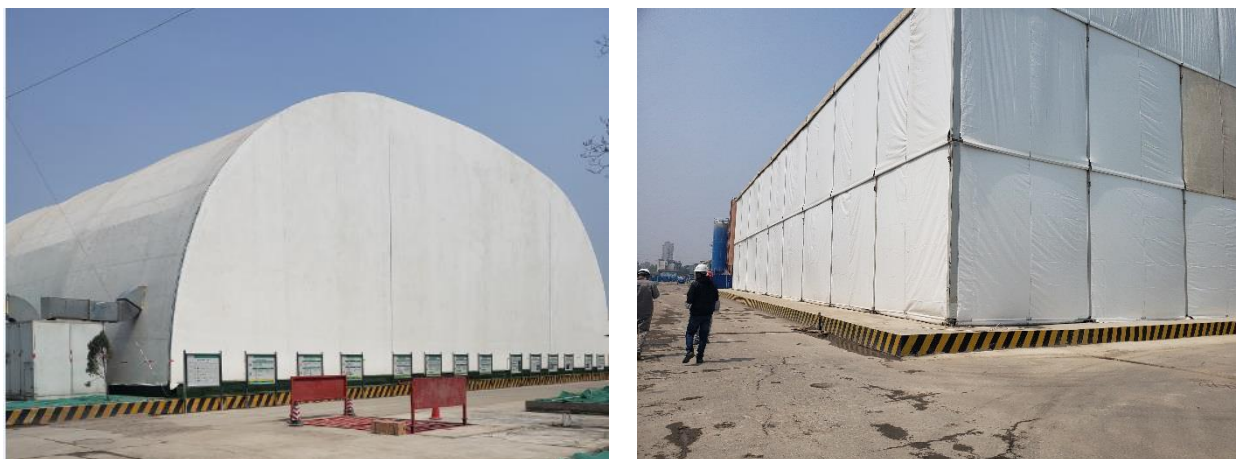
图 2-9 新建修复大棚照片
